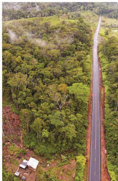
Рис. 42. Расчистка лесного массива под дорожное строительство
